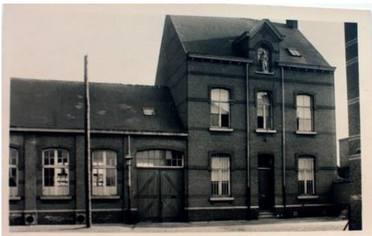
Figuur 141: De meisjesschool en het klooster zonder bovenbouw
