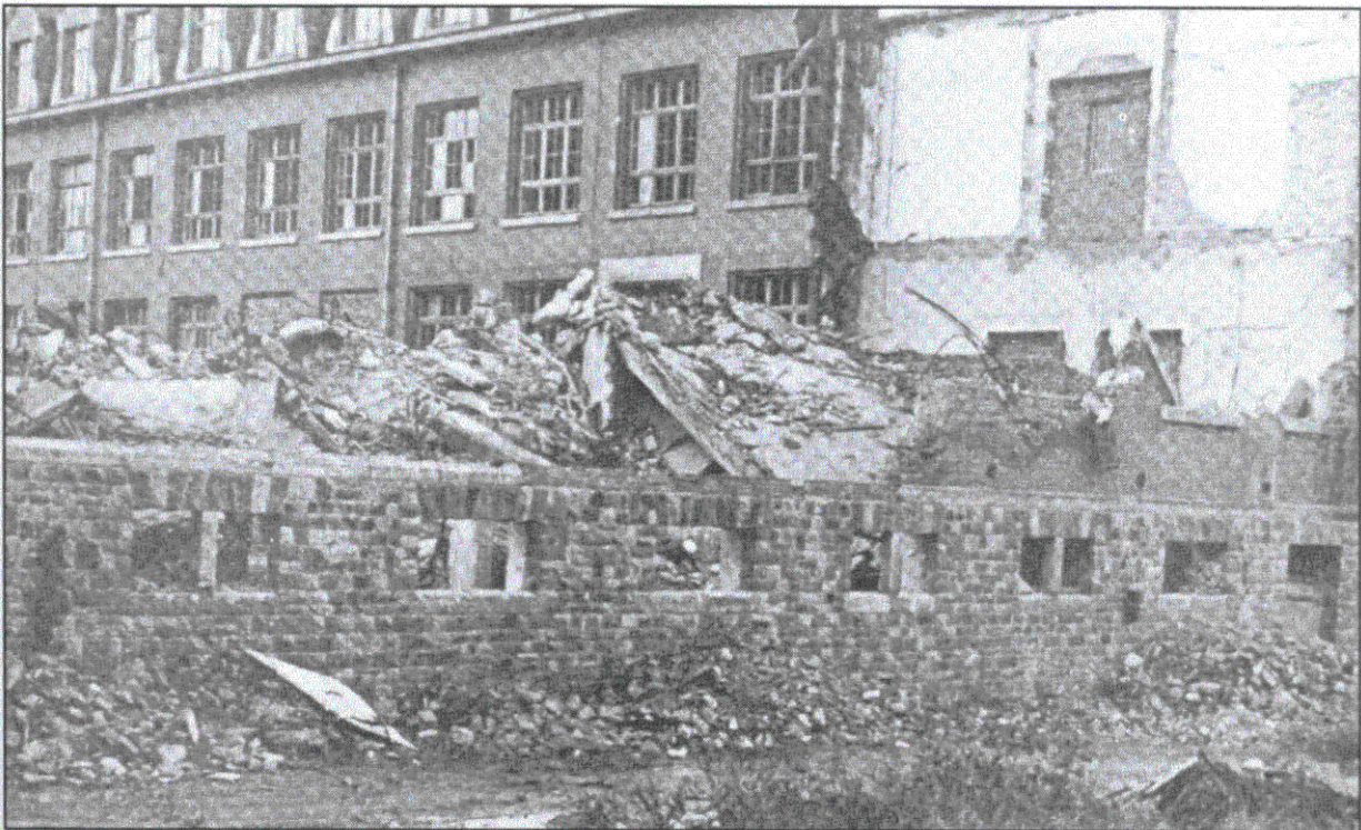
De totaal verwoeste kapelvleugel na een V-bom van 13 februari 1945
